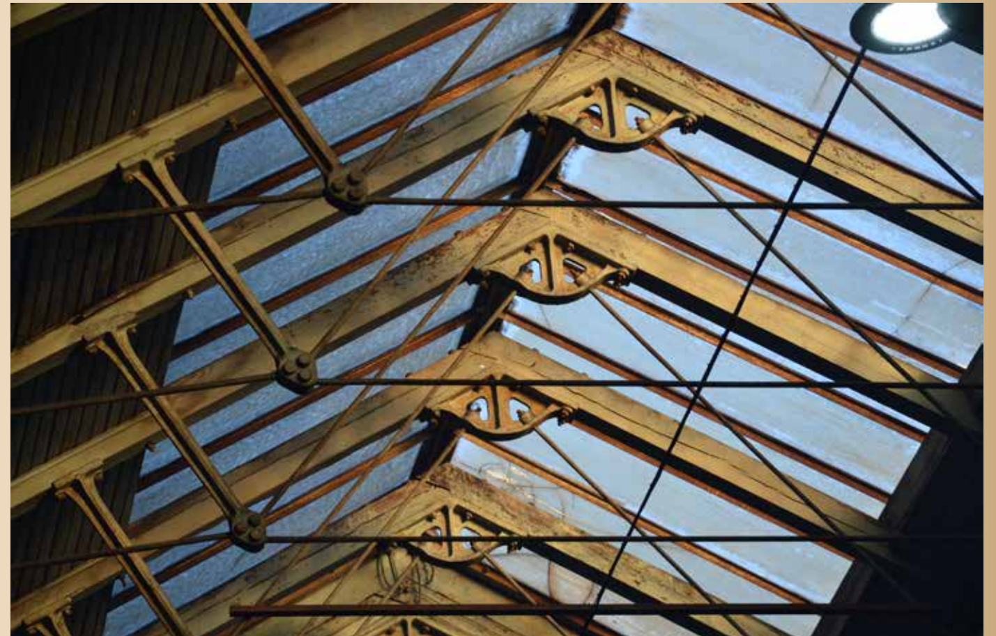
Takstolarna i Kohlswa Jernverks gamla lokaler där Joel håller hus visar på en omsorg om sånt som inte längre visas omsorg om.
